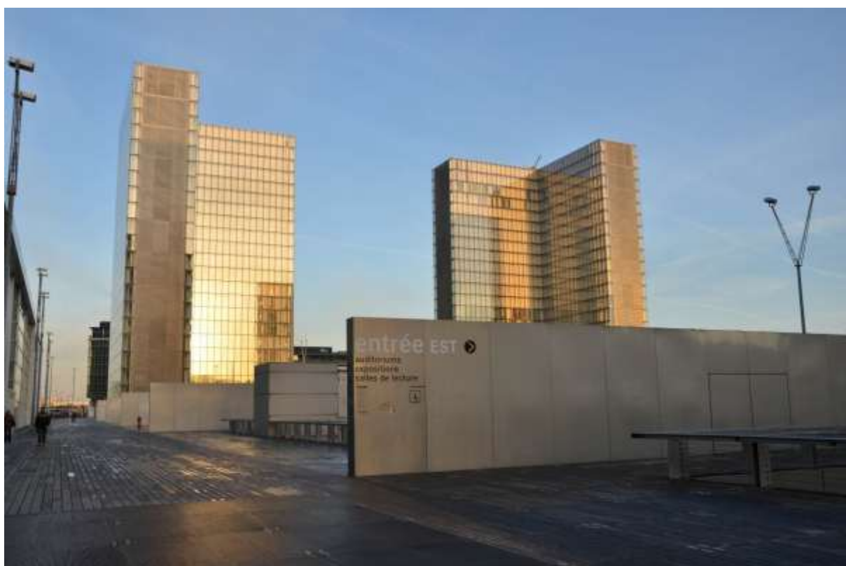
Hlavní budova BnF Francois-Mitteranda.
